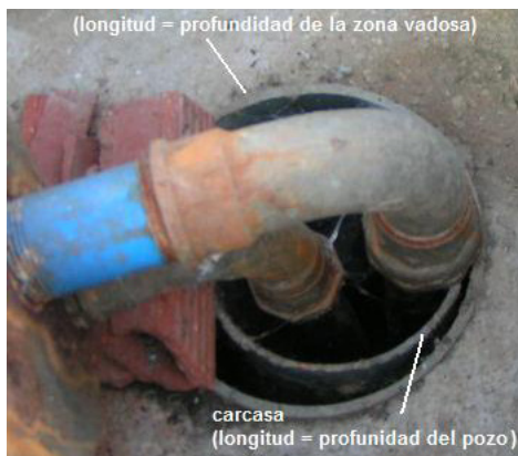
Figura 21. Detalles de execución de selo de morteiro e dobre entubado
