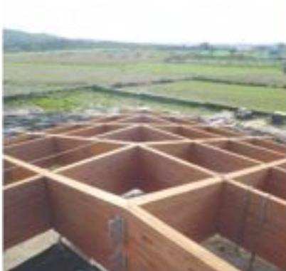
FASES DE EJECUCIÓN DE LA ESTRUCTURA DE MADERA DE LA CUBIERTA
