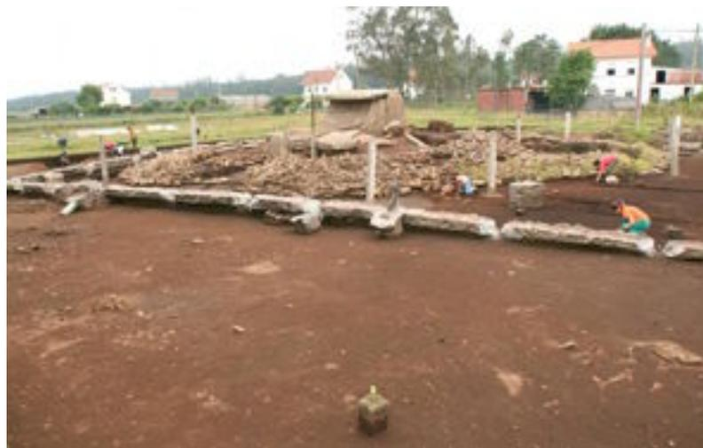
Excavación de la zona este del dolmen. La zapata de cemento ha sido cortada en fragmentos de tamaño medio, para proceder a su retirada en los días siguientes.
