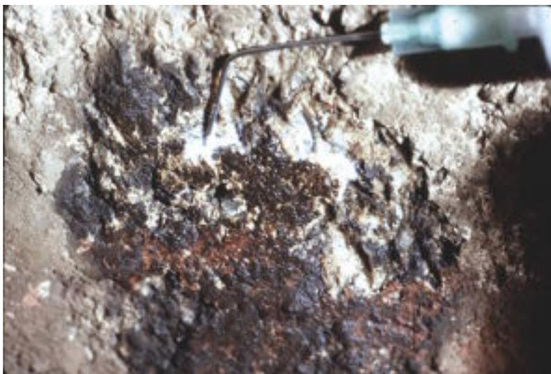
Inyección de adhesivo en una escama con riesgo de desprendimiento.
