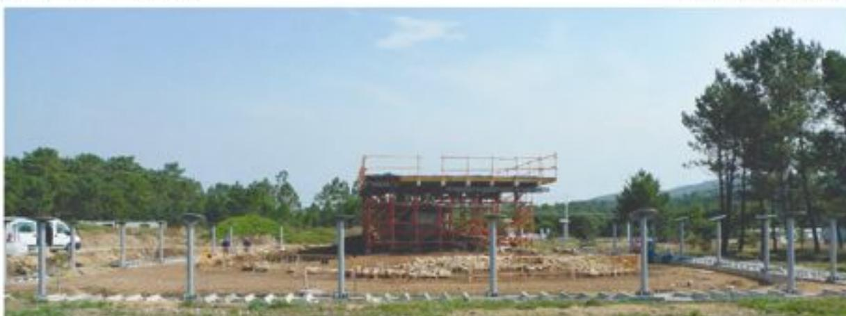
EJECUCIÓN DEL PERIMETRO ESTRUCTURAL, CON LOS PLARES PREPARADOS PARA RECIBIR LA ESTRUCTURA DE MADERA
