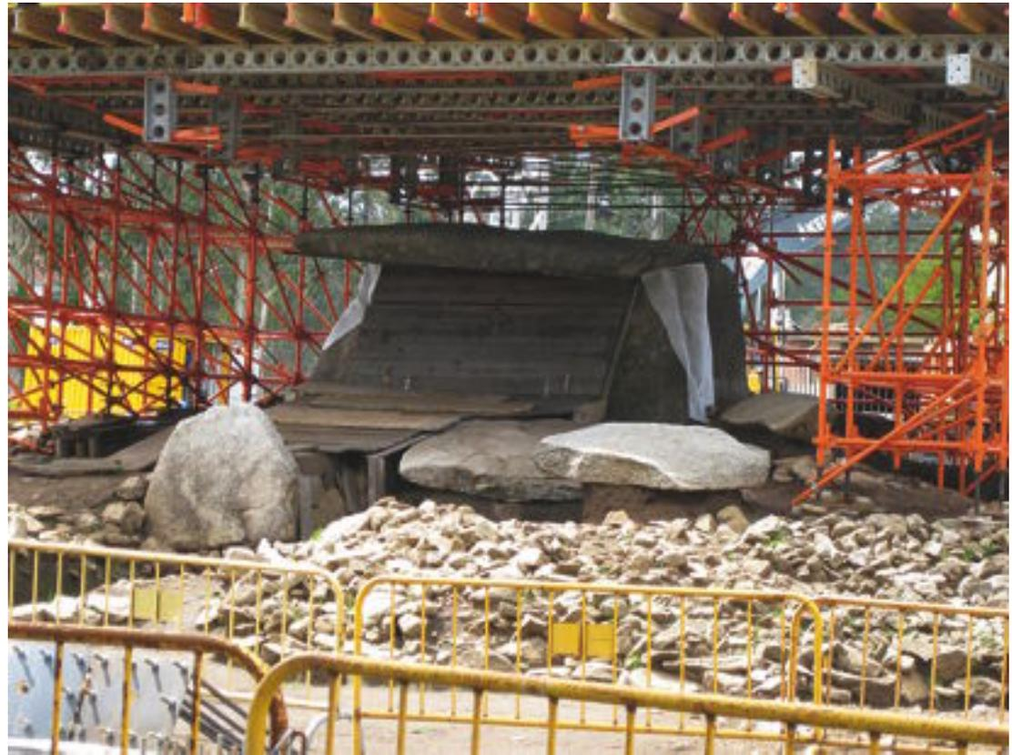
Detalle de la estructura de protección de madera. Sobre ella se observa la estructura metálica instalada para la protección del monumento durante las obras de 2010.
