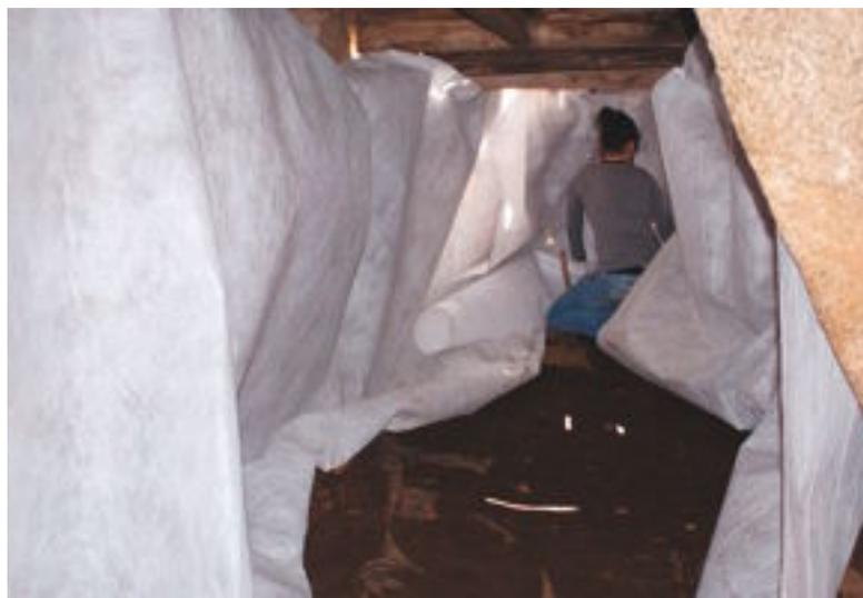
Colocación de geotextil en el corredor de Dombate.
