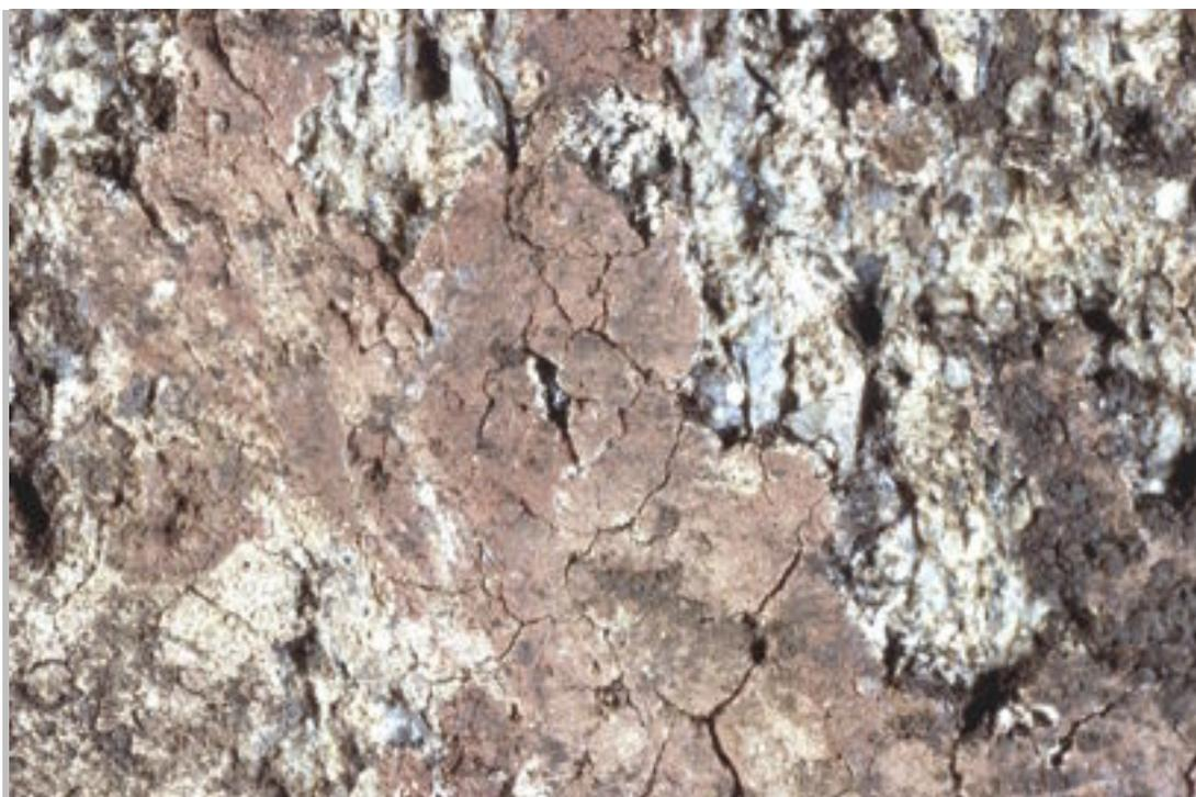
Detalle del agrietamiento de la pintura.
