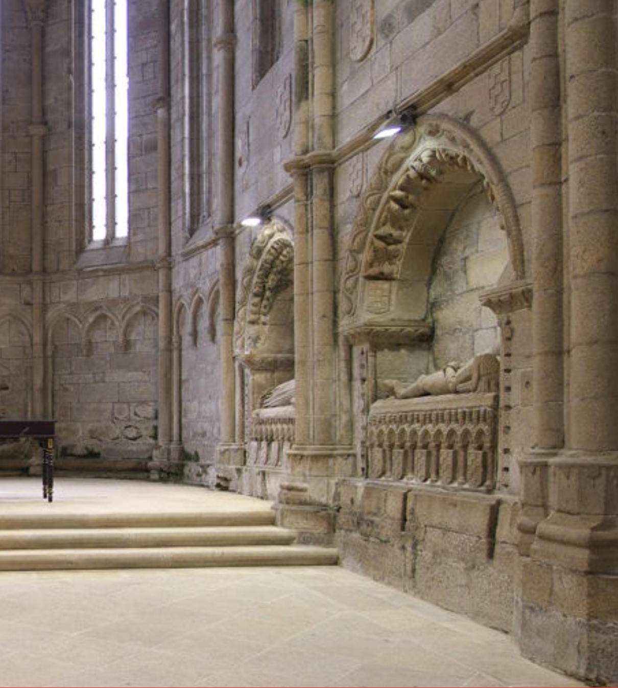
San Domingos de Bonaval. Capela maior
