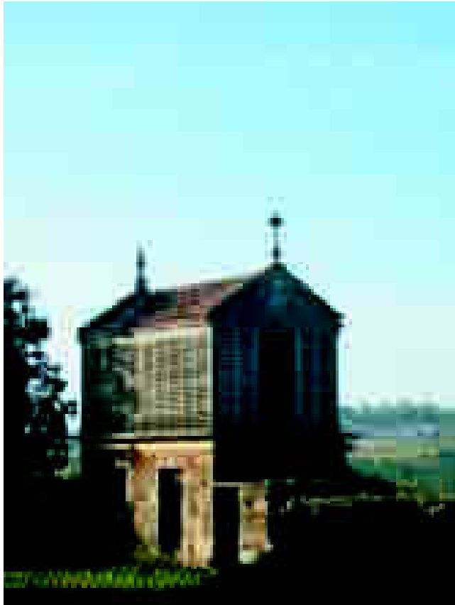
Hórreo de cara a 1950, que incorpora o formigón nos seus elementos máis significativos.
