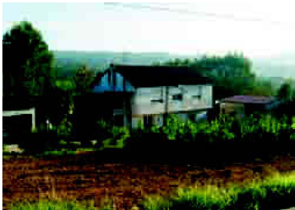
Vella casa de labrego transformada pola adición do voadizo, a apertura de ocós, a substitución da cuberta e o enfusado.
